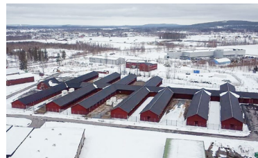
Rechenzentrum in Boden, Schweden: PUE = 1,09 (2023)
